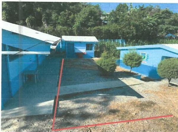
Foto 1: Mejoramiento instalacion de piso de concreto
