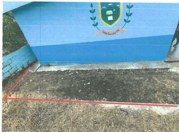
Foto 2: Mejoramiento instalacion de piso de concreto
